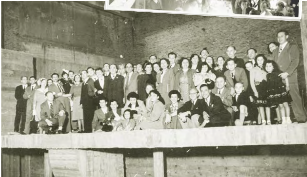
Distintos momentos de la construcción del edificio propio.
